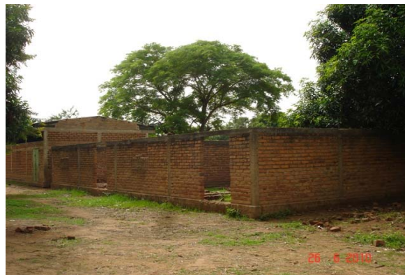
(Avant) Ecole Doumber II : Ancien bâtiment inachevé.
