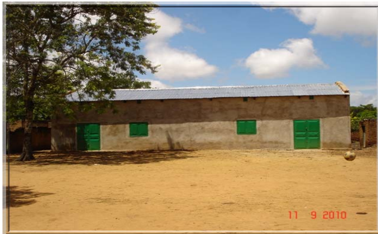
(Après) Ecole Bellevue : Bâtiment refectionné et couvert : Vue de l'exterieur.
