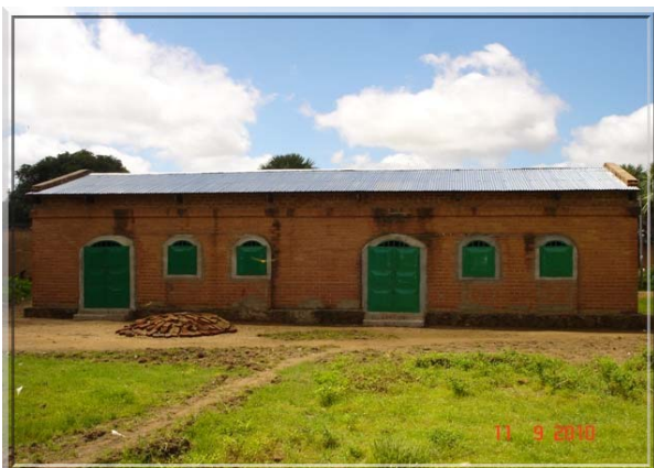
(Après) Ecole 15 ans : Bâtiment refectionné, toiture en tuile remplacée par la tôle : Vue de l'exterieur et de l'intérieur.
