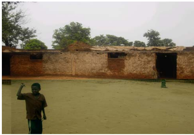
(Avant) Ecole Belle-vue : Ancien bâtiment inachevé.
